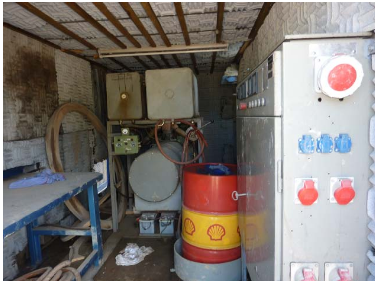
Bild-Nr: 632 Stromerzeuger 95 kva im 20 Fuß Container
