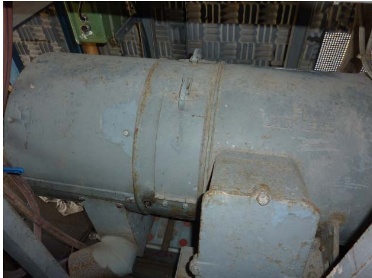
Bild-Nr: 626 Stromezeuger 95 kva im 20 Fuß Container
