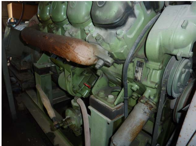
Bild-Nr: 623 Stromerzeuger 95 kva im 20 Fuß Container
