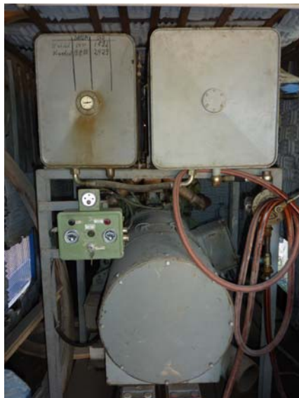
Bild-Nr: 629 Stromerzeuger 95 kva im 20 Fuß Container
