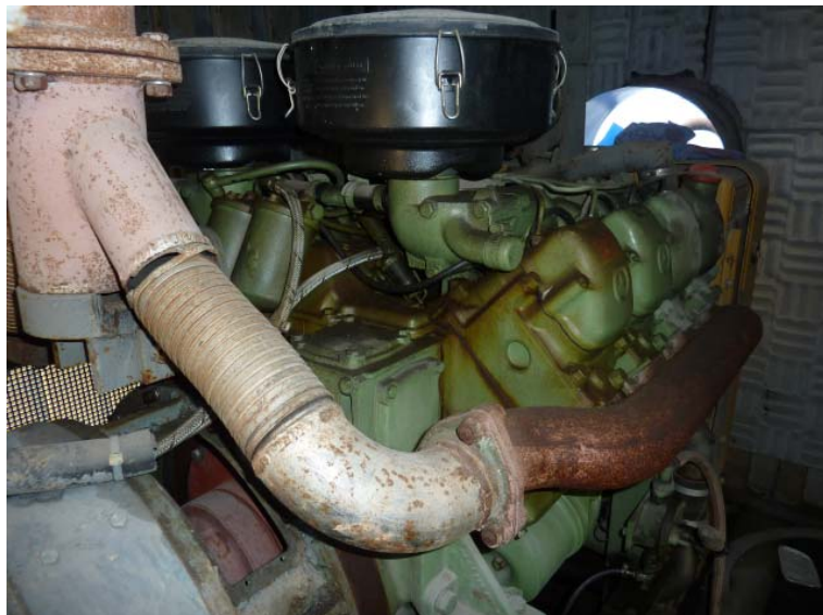
Bild-Nr: 623 Stromerzeuger 95 kva im 20 Fuß Container
